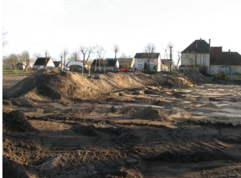
wymiana gruntu pod płytą boiska
