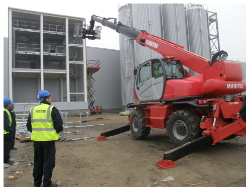
montaż konstrukcji metalowych
