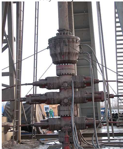
zabezpieczenie wylotu otworu
