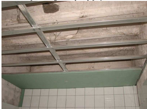
rusztowanie z płyt regips pod sufitem natrysków
