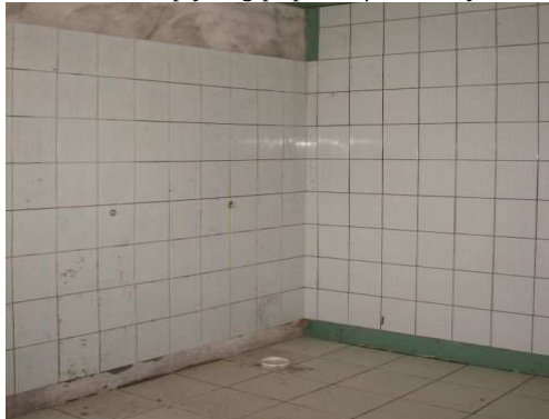
ściany wyłożone płytkami – pierwszy etap remontu
