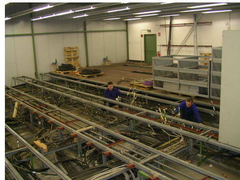
demontaż szaf sterowniczych przez naszych elektryków w Kutnie
