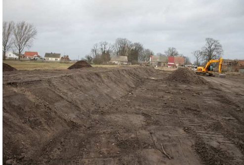
gotowy nasyp od strony północnej
