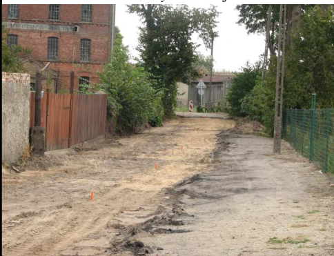
wykonanie koryta na ulicy Moniuszki
