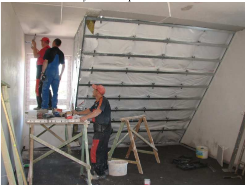
ocieplanie i położenie regipsów na poddaszu
