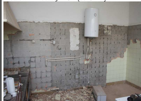
kuchnia w trakcie .....
