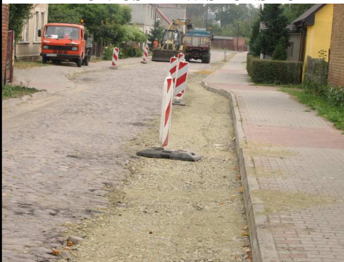
uzupełnianie podbudowy z tłucznia na ulicy Tkackiej
