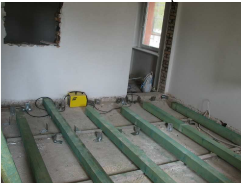
przygotowanie legarów pod podłogę
