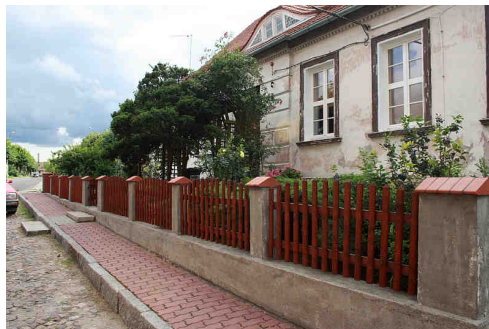
nowy chodnik i ogrodzenie przy plebani w Słońsku
