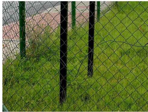
przecięty drut naciągający siatkę
