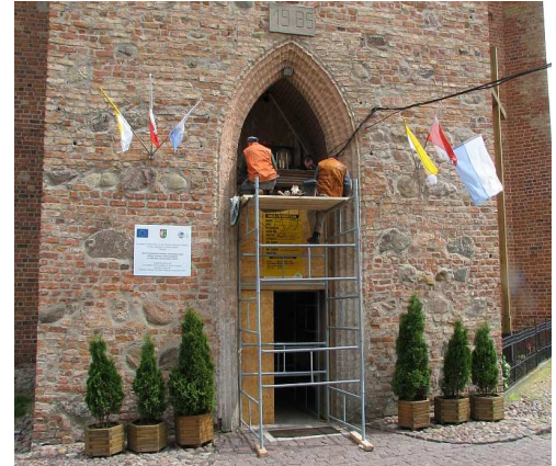
prace przy montażu odnowionych drzwi głównych w kościele w Słońsku
