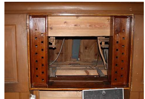
organy w trakcie renowacji
